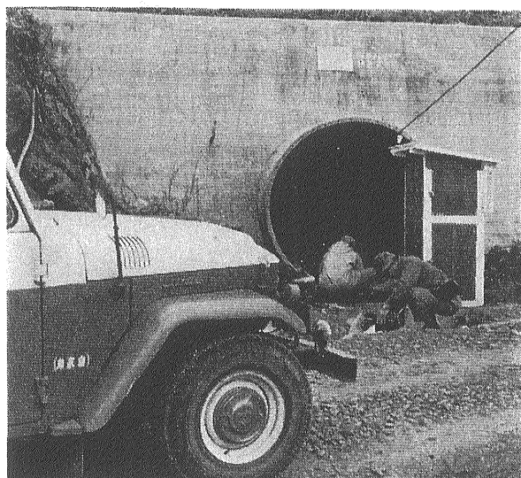
③ 地すべり対策排水溝 山腹に施行された内径2m 延長167mの排水トンネル 地下水の中立圧を低下させることによって地すべりを防止するもの
