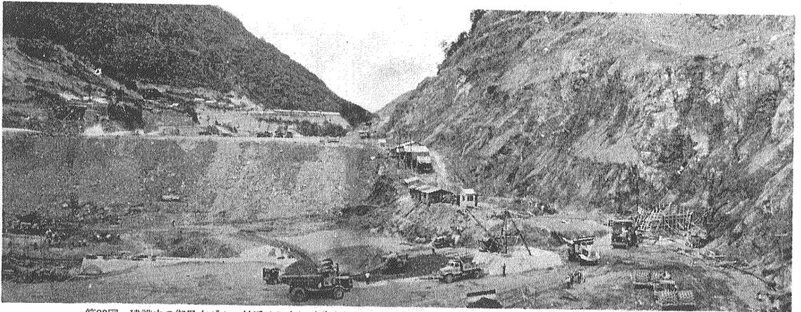
第93図 建設中の御母衣ダム 付近はおもに破碎された面谷(濃飛)流紋岩類からなり これを諸所で白川花崗岩が貫いている
