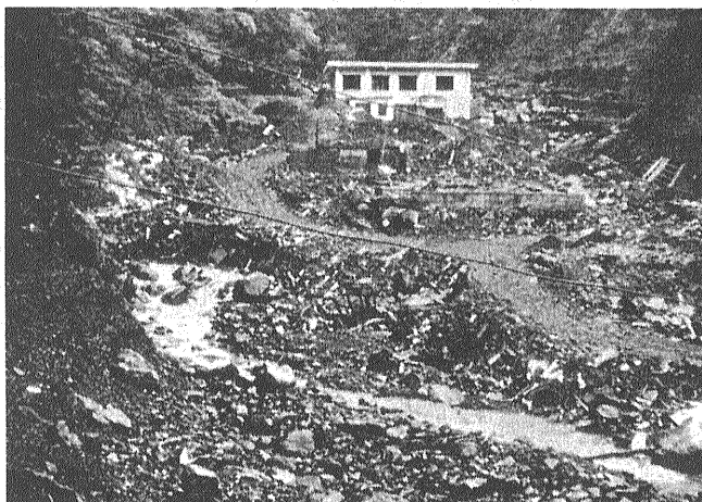
梅ヶ島温泉の被災跡(10月後の状態)温泉地のの上流側の部分 谷間の河原地帯に作られた新しい温泉旅館(寿屋・さかや・泉屋)が土石流で破壊された惨状
