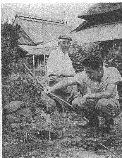
④ 硬質ビニール管（ガス導管）の途中にペントナイト層を置き 大気としゃ断する
