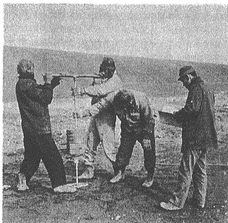
F-9 a. スウェーデン式サウンディング法の野外作業状況 回転貫入を行なって地耐力を測っている
