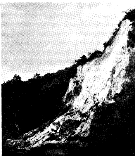
第22図 シラスの崩壊(伊集院町国道ぎわ)
