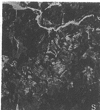
第24図 第23図の東側で古生層の地すべり地 山崩れはほとんど発生していない
