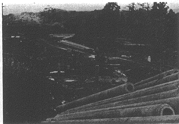
第8図 長さ12mの杭を打ち地すべりを止める
