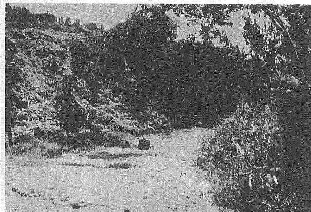
⑥ 地すべり末端で泥流が道路にのしかかっている(胡桃)
