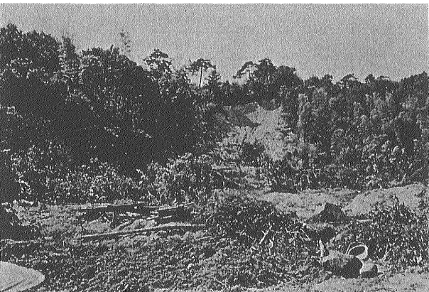
花崗岩地域のマサの崩壊(三刀屋町給下地区)
