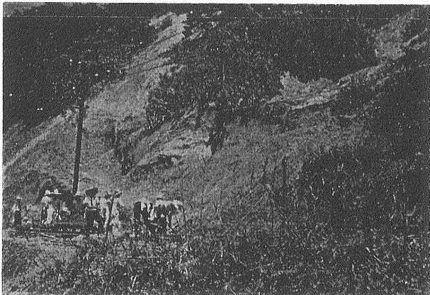
布志名層 (砂質泥岩) の崩壊 (出雲市和井宮駅付近)
