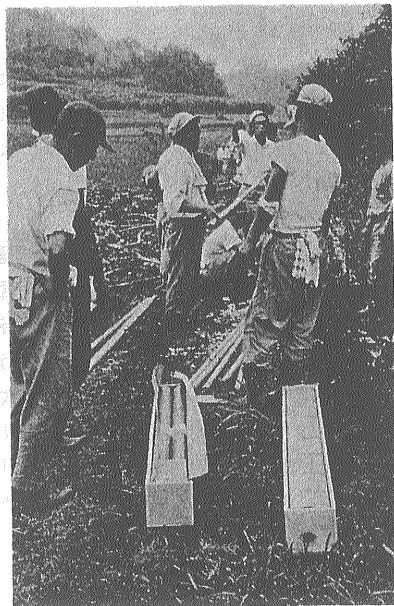
ダイナマイトの装填作業 (木箱の中に見える円筒形のもがダイナマイト)
