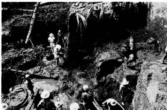
第3地区バンタルカロン鉱床の東側採掘切羽 凝灰岩中の同時性堆積鉱層 平均品位 Mn 26%
