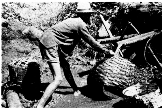
鉱石の水洗 竹製ザルの中でガサガサやる 第2地区 上部ビビジラン鉱床にて
