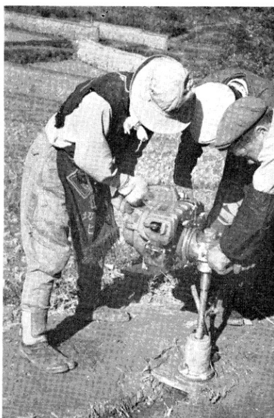
簡易試錐機(バックサック)によるγ線検層孔の掘さく(最高深度30mまで掘さく可能)
