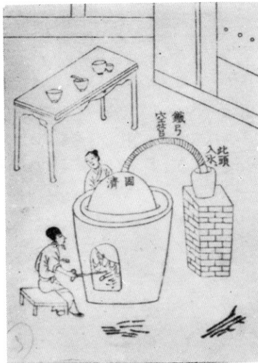
水銀升鍊図(天工開物) 〔水銀の蒸溜〕
