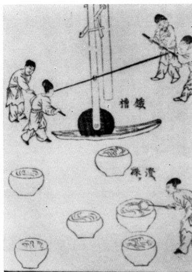
碓を研する図(天工開物) 〔辰砂の粉碎〕
