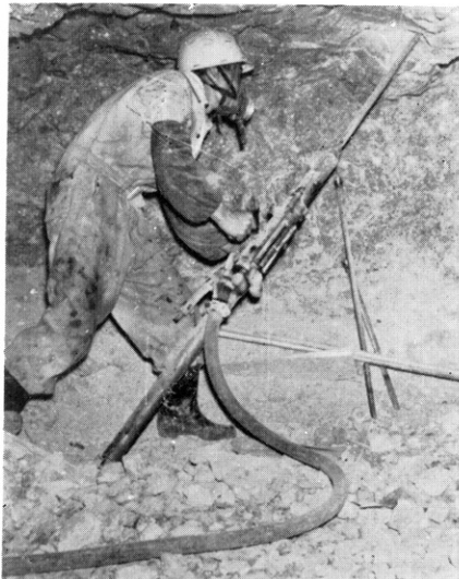
坑内におけるドリフター (イトムカ鉱山) (野村鋳業KK提供)
