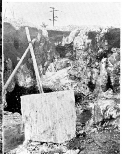
採掘された大理石 電気ドリルの穿孔跡がみられる (写真3葉は山陽大理石KK提供)
