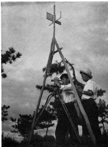
新らたに設置した基点三角点の観測作業
