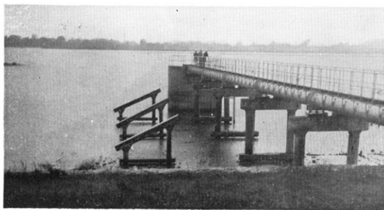
水量豊かな阿賀野川の表流 90,000 m 3 /日 を取水する日本ガス化学の新潟第2工場の水源
