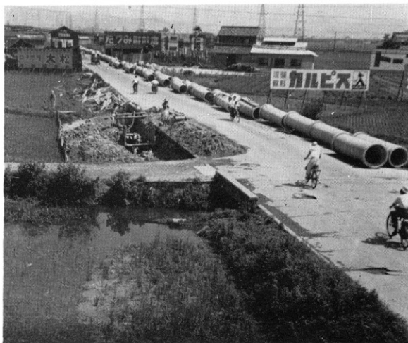
工業用水法の施行に伴ない通産省の行った工業用水道第1号となった尼崎市の工業用水道主管の埋設工事 (昭和32年6月当時)
