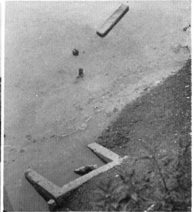
1m近い地盤の沈下で排水口が干潮時にも河水面下に没してしまつた (横浜 鶴見川 森永橋附近)
