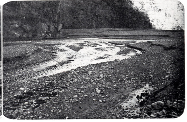
大井川支流寸又川千頭貯水池の砂のたまりかた (えん堤上流150m 31年12月) この貯水池のえん堤は高さ64m(重力式) 総貯水量 495m 3 であつた (中部電力kk提供)
