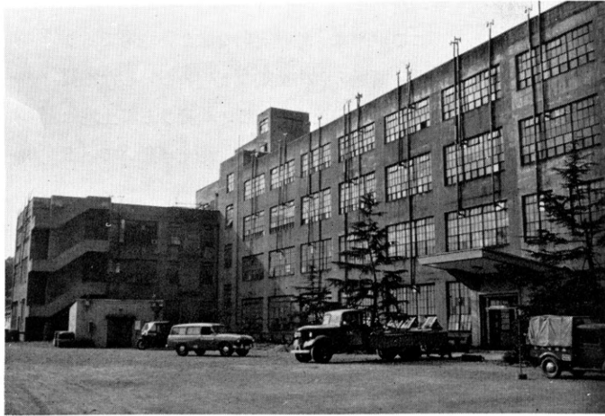
地質調査所講ノロ庁舎の一部
