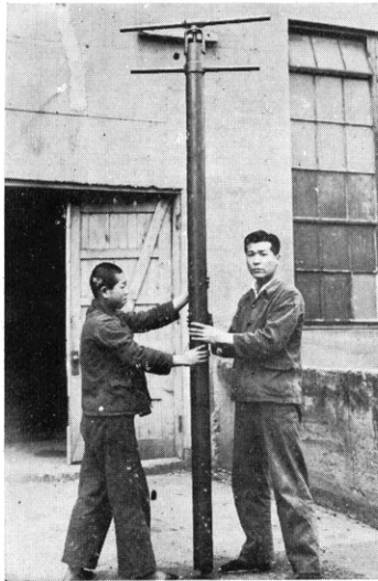
砂鉱用スパイラル [海浜砂地の浅い層の砂鉄調査に使用]
