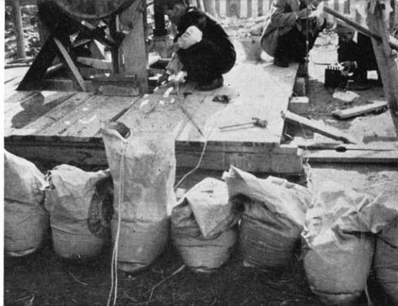
孔内の電気検層
