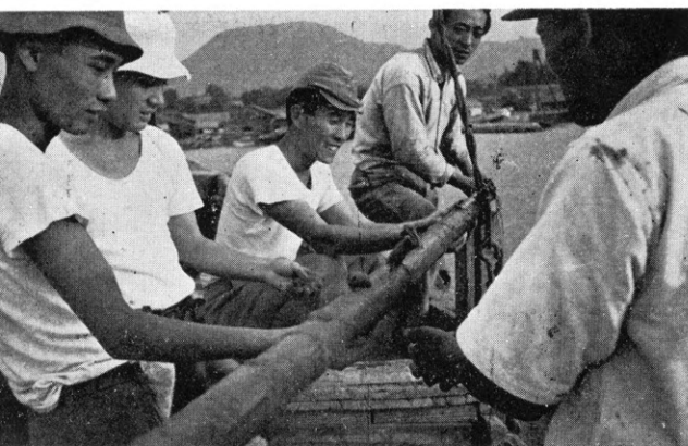
② ガス管から採取した粘土の押出し作業
