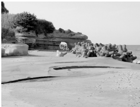
写真25 小良ヶ浜の北側の海蝕崖。奇岩のまわりにもテトラポッドが積み上げられています。
