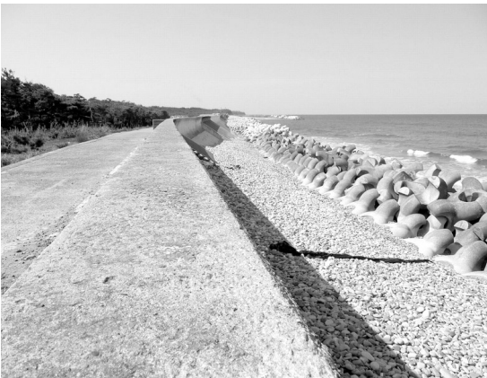
写真14 護岸堤の先。狭い砂礫の浜の先にテトラポッド列が続き、荒波が打ち寄せていました。
