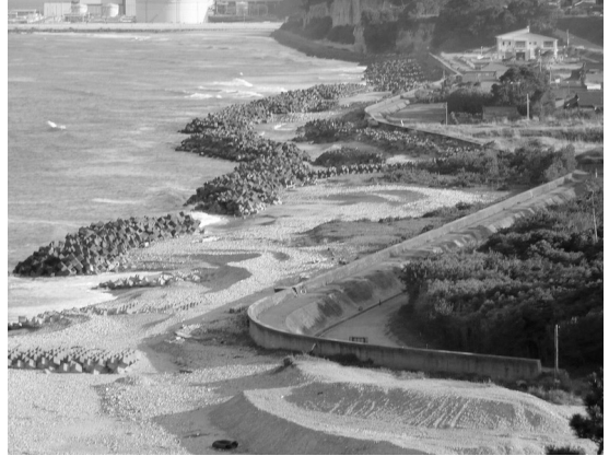
写真31 天神岬から見た木戸川河口部の海岸。高い護岸堤とテトラポッドの列が見られます。
