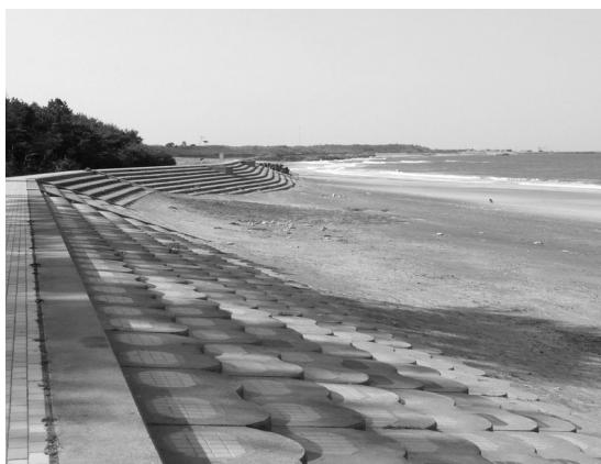
写真20 階段状護岸が整備され, その先にヘッドランドと離岸堤に守られた浜があります.
