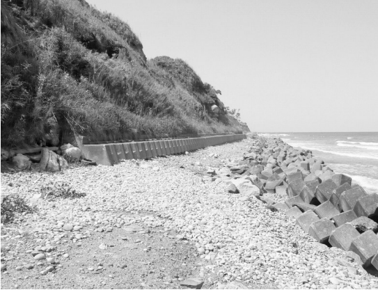
写真5 太田川河口北側の海岸。海蝕崖の下に護岸堤、テトラポッドの列が見られます。
