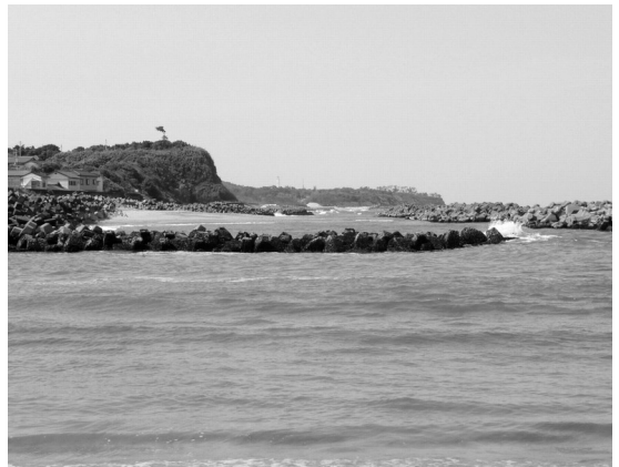
写真8 小高川河口北側の海岸。ここにも海蝕崖の下に護岸堤、テトラポッドの列が見られます。
