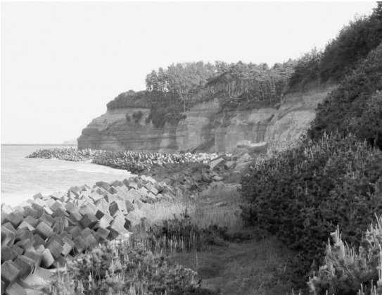
写真22 双葉海岸南側の海蝕崖。浸食を防ぐために大量のテトラポッドが投入されています。
