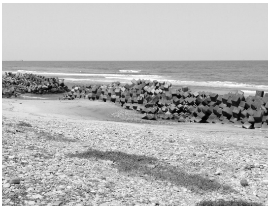
写真3 萱浜海岸. 護岸堤と離岸堤の間に砂礫の浜があり, 一部に砂の浜が残されています.
