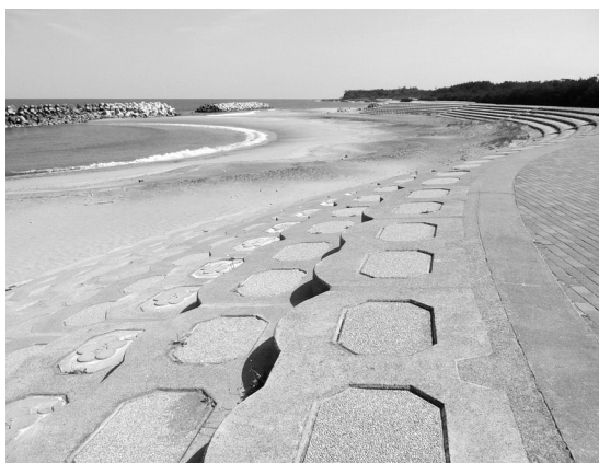
写真10 村上海岸の人工海浜. 湾曲した護岸の先に人工海浜が造られています.
