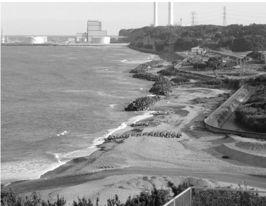
写真30 天神岬から見た木戸川河口部の海岸。後方は広野火力発電所。
