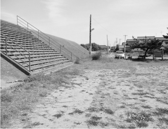
写真13 高い護岸堤。民家の2階の屋根ほどの高い護岸堤がどこまでも続いています。
