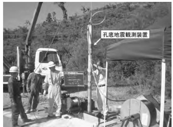
第1図 孔底地震観測装置(株式会社ミットヨ製)の外観。円筒形のステンレス容器の中に地震計が納められています。写真は井戸に設置する直前に撮影したものです。
