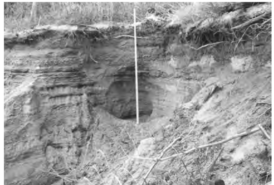
第13図 3mのスケール下部に空いた穴はパイピング跡. 背後は枯れかけた樹木と廃棄場.
