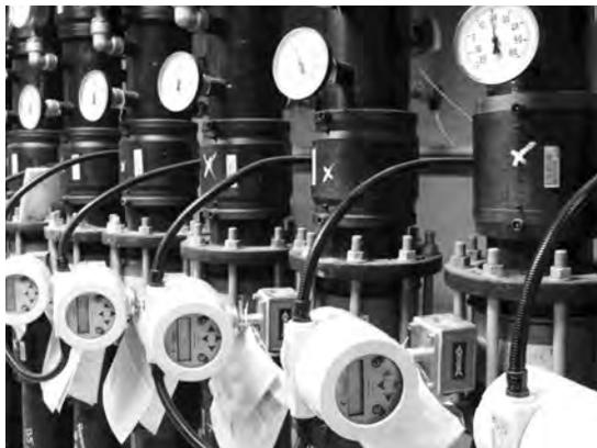
写真12 坑井への注水と揚水は圧力計と流量計で管理する。バルブの切り替え操作で、同一の坑井で注水または揚水のために使うことができる。
