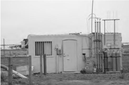
第11図 貯留流体モニタリングなど各種観測の拠点となる施設。外には流体採取用の窒素ガス・ポンペなどが並ぶ(相馬宣和撮影)。
