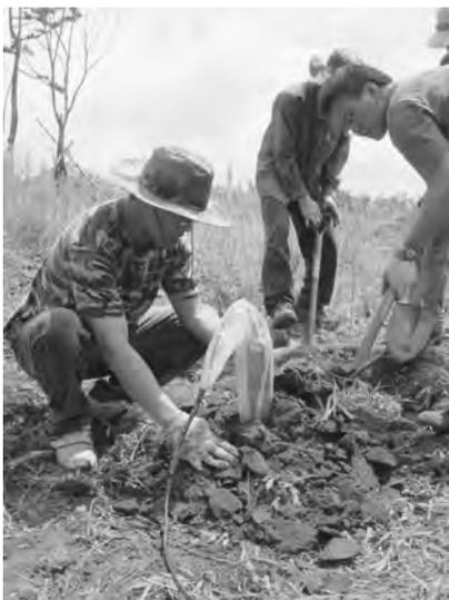
写真4 鉛直磁場センサーの設置. 溶岩が多く, 十分な深さまで埋めるのに苦労する.
