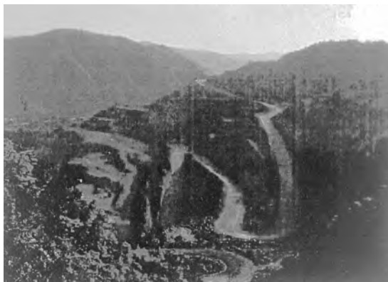
写真5 西ピットから見る中央ピット。
