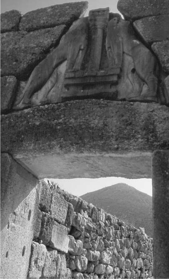
写真4 ミケーネの獅子の門とまぐさ石。獅子の像は石灰岩で造られているが、まぐさ石など周囲の石材は鮮新世～更新世の礫岩を用いている(撮影 蟹澤, 2006)。
