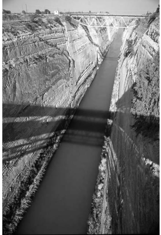
写真9 コリントス運河。ところどころに正断層がみられる。全長6,343メートル、内壁の最高点は79.5メートルに達する(撮影 蟹澤, 2006)。
