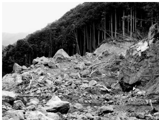
写真7 地すべりダム。写真右方に、スケールになる人が写っています(白矢印)。大量の土砂が、春日谷の本流をせき止めたことが分かります。地すべりダムを下流側から見えています。
