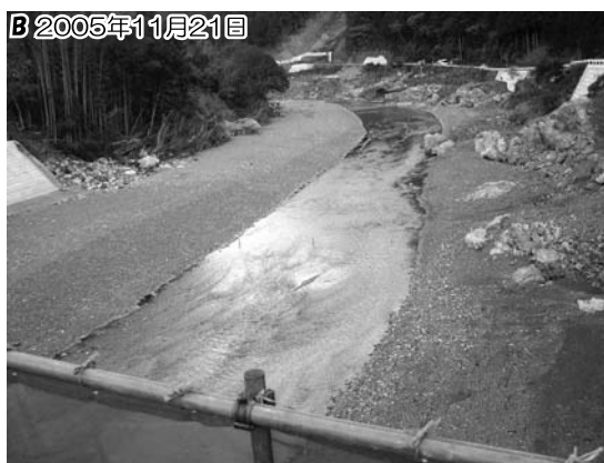
写真1 被災後の宮川の河床状況。春日谷との合流点から下流方向(東方向)を見えています。
