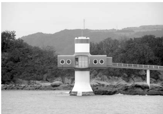
写真20 海中展望塔「足摺海底館」.
