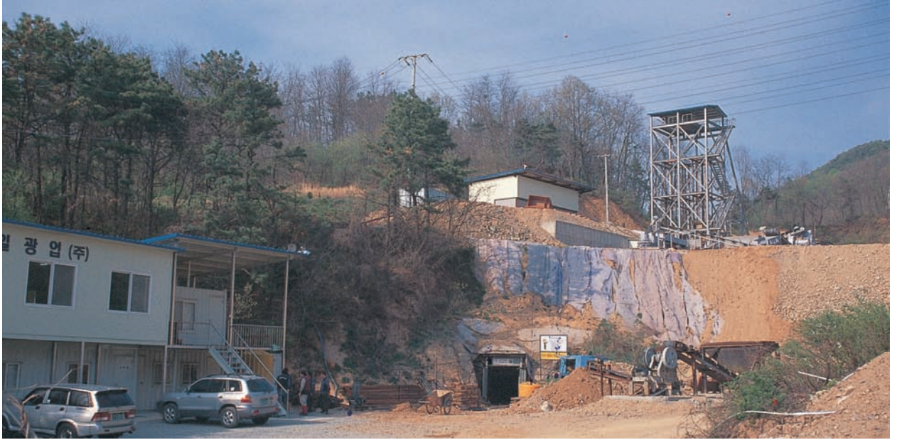
4. 再開発中のムクック鉱床の西端部.
