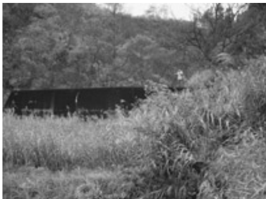
写真1 砂防ダム。当地域には写真のようなダムが多数存在し、地震観測には比較的良好な場所を提供してくれる。
