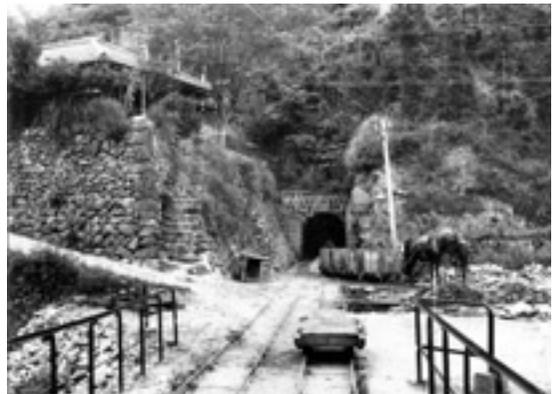
写真2 芹ヶ野坑通洞坑口(昭和3年)。芹ヶ野坑は二坑と称した。鉦石を搬出には、馬に引かせたトロッコを利用した。
