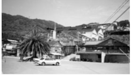
写真12 現在の青化製煉工場。初代の工場は大正3年に建設されたが、現在のものは昭和25年に立て直された。耐酸性を考慮して巨大な木造構築物となっている。
