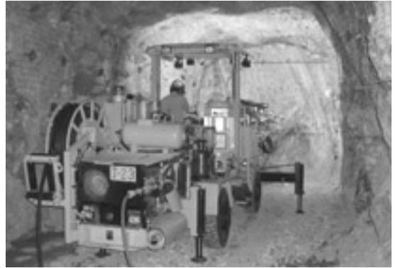
(a) 1ブーム・ドリル・ジャンボ。鍾押坑道の掘進発破のために穿孔している様子。
