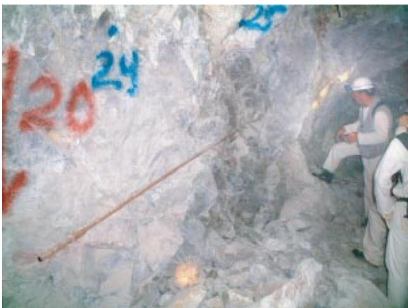
1. 1999年4月, 南アフリカ共和国 Matjhabeng 金鉱山の地下約1.4kmで M4.6の地震が発生した. 震源は金鉱脈を上下に約1km 変位させている Dagbreek 正断層で, 地震に伴う数cmの地表の上下変動が人工衛星によって確認された. 写真は, 2002年に南アで開催された ICDP Workshop Drilling Active Fault in South African Mines の際に, van Aswegen 博士とReches教授によって企画された巡検中に筆者が撮影したものである.
