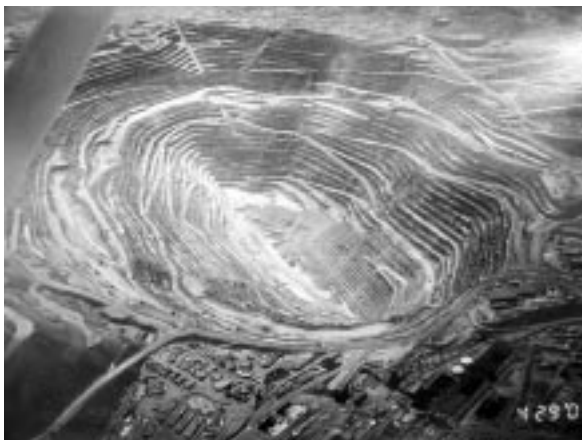
第1図 チュキカマタピットの写真(2000年4月撮影)。
