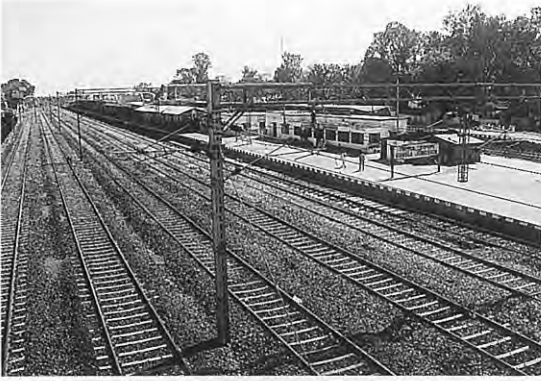
写真3 ゴンディア駅の構内、軌道幅が広い。
