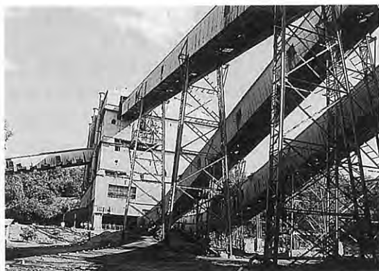
写真32 一次破碎から二次破碎室へのベルトコンベア。
