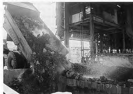
写真31 クラッシャー室への鉱石積み下ろし風景。
