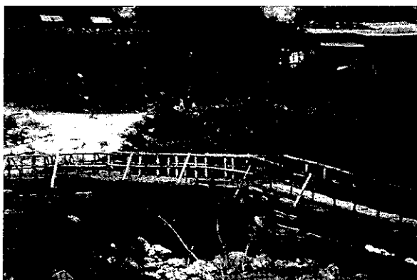
写真5 ブータンには多くの種類の橋があるが、長い橋はこのような構造が多い。山梨県の猿橋と同じ構造である(青年海外協力隊、小池 徹氏撮影)。
