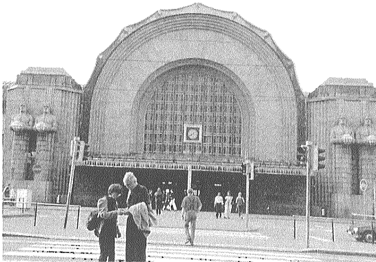
写真1 赤色花崗岩の壁に緑の屋根を持つヘルシンキ中央駅。
