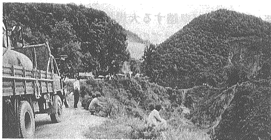
第9図 小規模な崩壊によって途絶した昆明-東川市間の国道. この時は, わずか2時間程度で復旧した.
