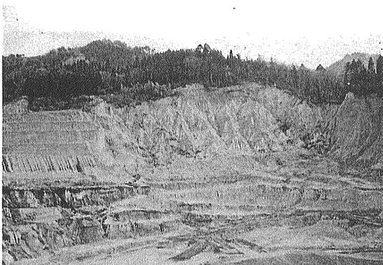
写真6 採掘場の中央奥の状況。正面には粘土層や砂礫層ではなく破碎された花崗岩がみられる。
