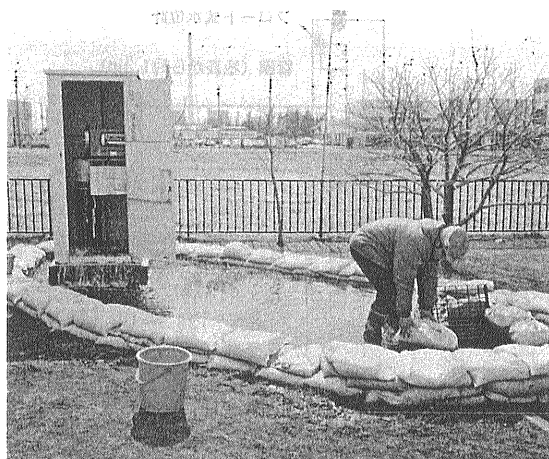
写真1 観測1号井の自噴風景(4月14日)。観測建屋のドアから水があふれ出ている様子がわかる。建屋内には井戸があり、約1.3mの高さから地下水が湧き出している。
