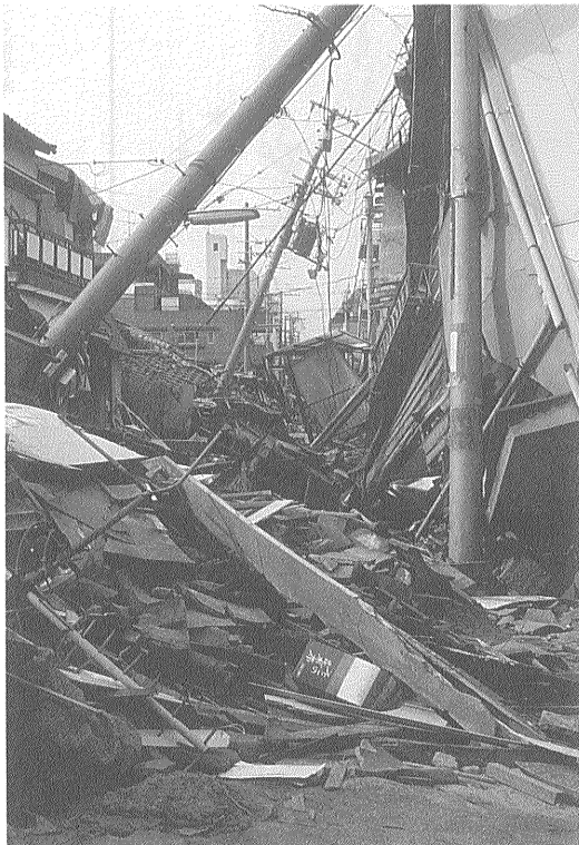
第5図 木造家屋の被害状況。
