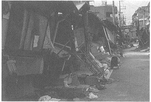
第6図 木造家屋の被害状況。
