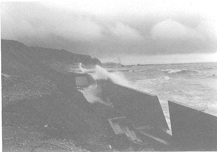
第12図 突堤北方の護岸破壊状況 (1977年5月撮影)
