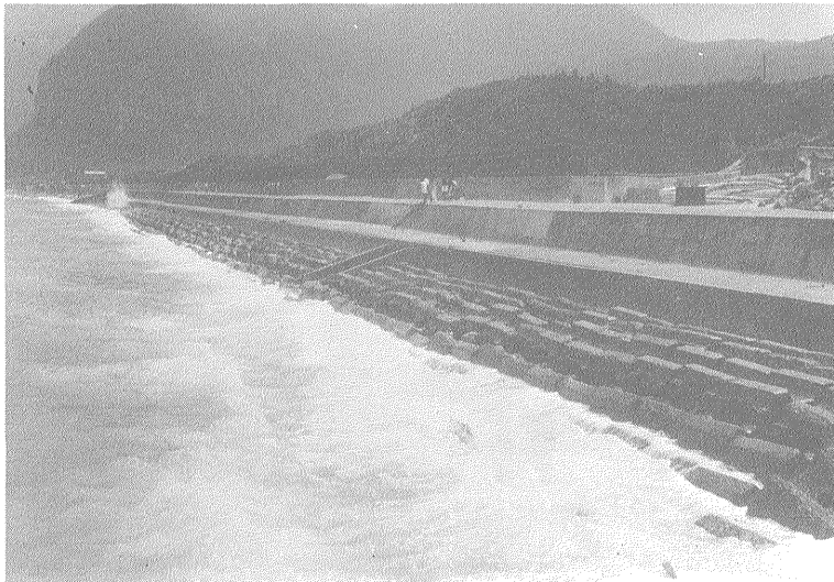
第16図 消失した砂浜と新護岸 (手前は消波ブロック, 人の歩く位置が旧護岸上部に対応)
