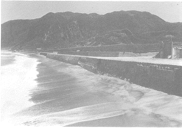
第15図 減少した砂浜と修復された旧護岸 (1977年5月撮影)
