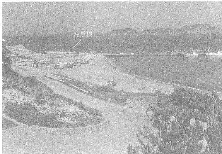
第18図 埋積された新島港（第5図と同一位置から1977年5月撮影）
