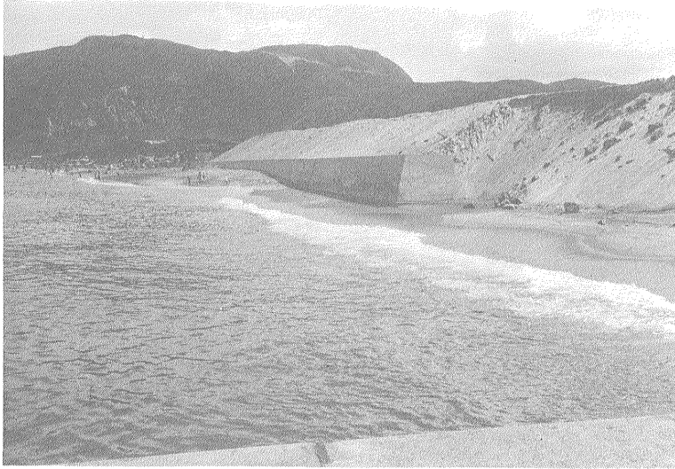
第13図 突堤北方の砂浜の侵食状況と浚渫土砂の盛土崩壊（1975年8月撮影）
