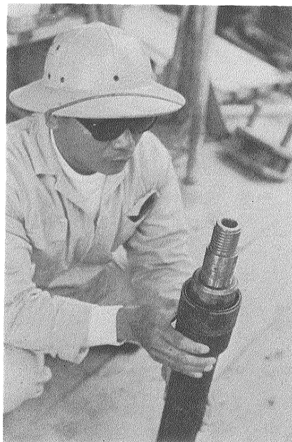
10. ケーシング挿入用左ネジ カップリング
