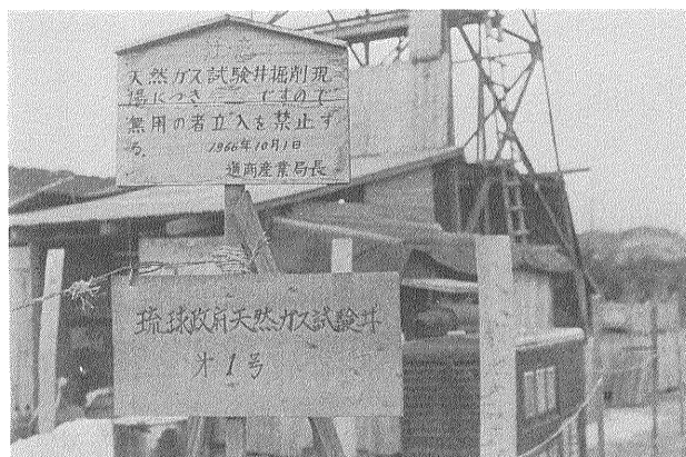
2. 那覇1号井掘さく現場入口
