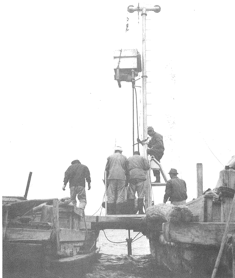
第14図 双船式を使用し懸吊型試錐機の海上実験（カトルクワイヤー使用）
