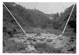
図版 4 野津原ダム計画線 河床に基盤の一部を露わす
