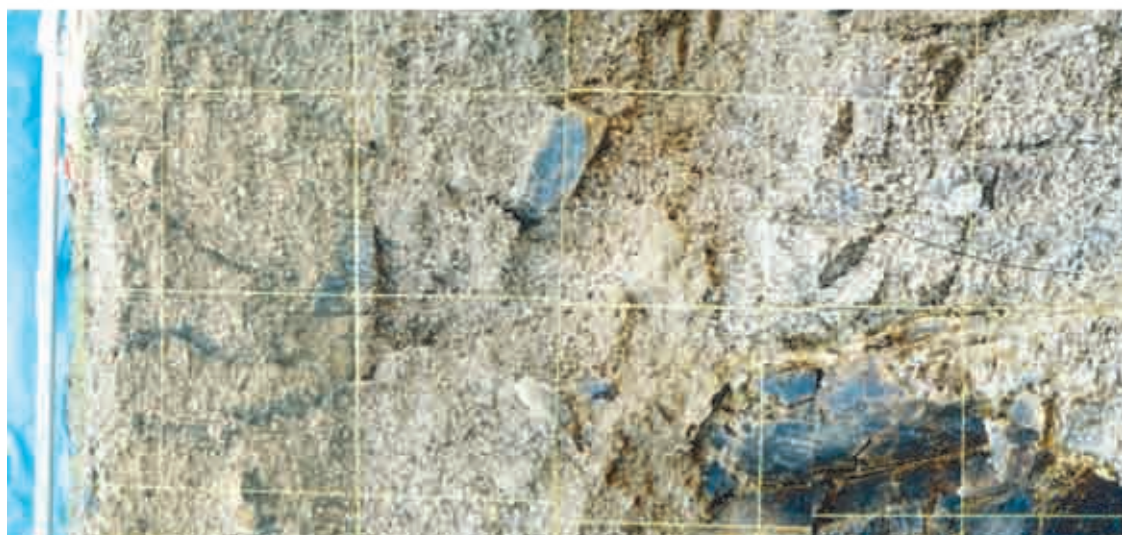
写真4. P1-1トレンチ北西側壁面の断層部の拡大撮影（第4図参照）。 Photo 4. Close-up of the fault zone on the northwest wall of the trench P1-1. See Fig. 4.
