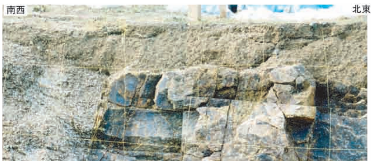
写真8. P1-2トレンチ北西側壁面の断層部の拡大撮影（第5図参照）。 Photo 8. Close-up of the fault zone on the northwest wall of the trench P1-2. See Fig. 5.
