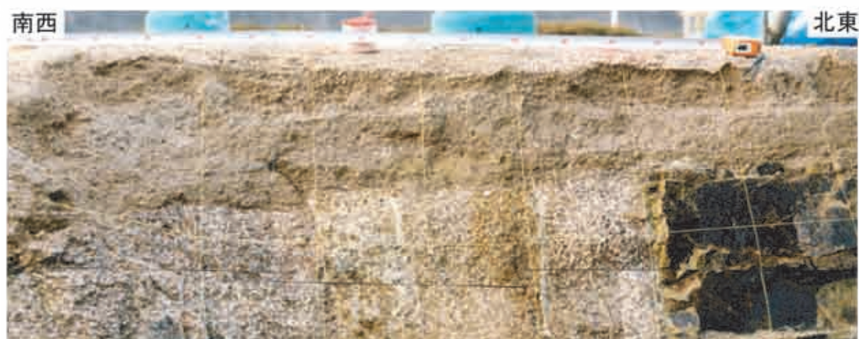
写真10. P1-3トレンチ北西側壁面の断層部の拡大撮影（第6図参照）。 Photo 10. Close-up of the fault zone on the northwest wall of the trench P1-3. See Fig. 6.
