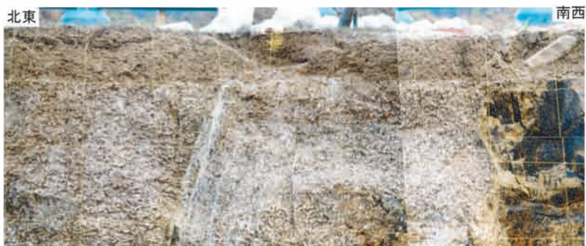
写真9. P1-2トレンチ南東側壁面の断層部の拡大撮影（第5図参照）。 Photo 9. Close-up of the fault zone on the southeast wall of the trench P1-2. See Fig. 5.
