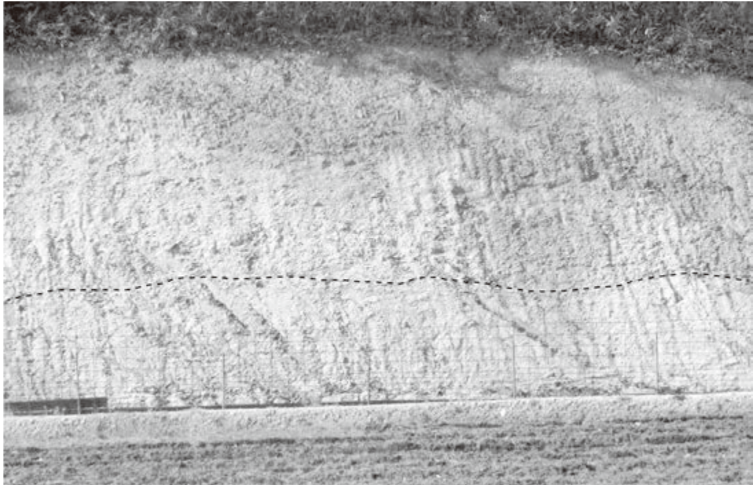
第 9.5 図 竹成断層に沿う神田層の急傾斜帯と不整合の露頭 三豊市財田中入樋(付図 1 の地点 9.1 の西). 下部は淘汰の悪いシルト主体層で北方に急傾斜しているが、破線より上位の砂礫主体層はそれらを不整合状に覆っている. 露頭の高さは約 8 m. 北西方を望む.
