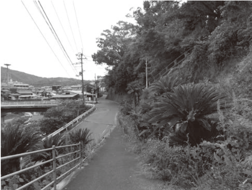
第9.1図 池田断層の低断層崖 三好市池田町池田市街地北. 西方を望む.
