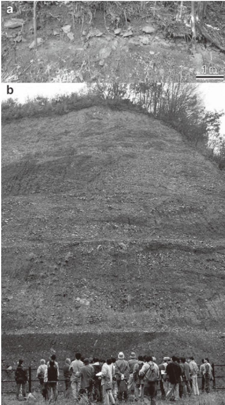
第 8.5 図 地すべり堆積物の露頭写真 地すべり地域に見られる角礫層。中礫～巨礫サイズの角張った和泉層群の砂岩礫を含み、非常に淘汰が悪い。(a) 地すべり崩落崖の冠頂付近に見られる角礫層。三好市池田町西山(付図 1 の地点 8.27)。この地すべりにおける角礫層の厚さは 42 m に及ぶとされる(長谷川, 1992b)。(b) 池田町シンヤマの地すべり堆積物。池田町シンヤマ(付図 1 の地点 8.28)。写真撮影位置は付図 1 に示す。
